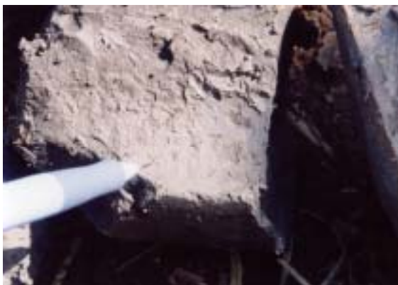
写真-1 アンカー孔壁の粘土化状況 (試験孔No.1。泥岩 = 1.1N/mm 2 。66mm掘削後、115mmでリーミング時に採取。粘土化面は66mm孔壁)
