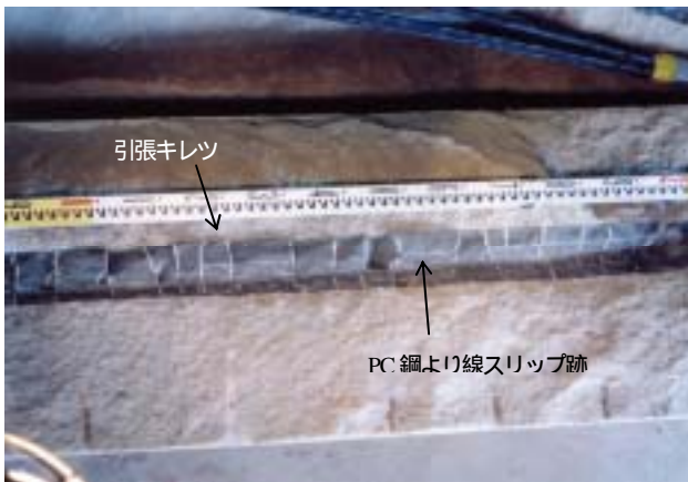
写真 - 5 摩擦型アンカー体解体状況
