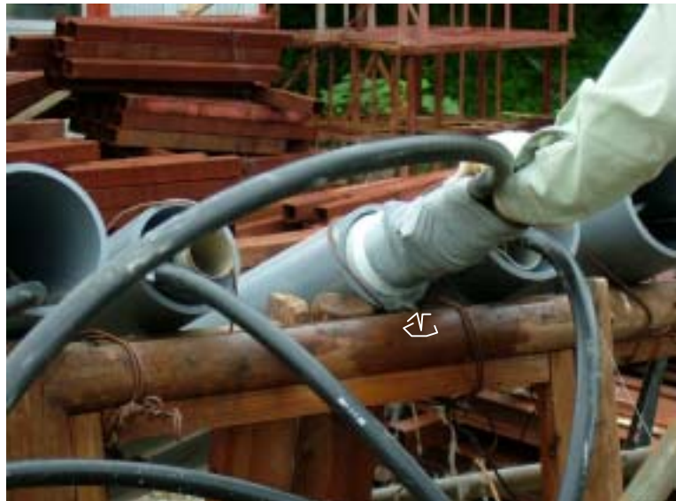
孔内水の噴出とアンカー体の抜け上がり
