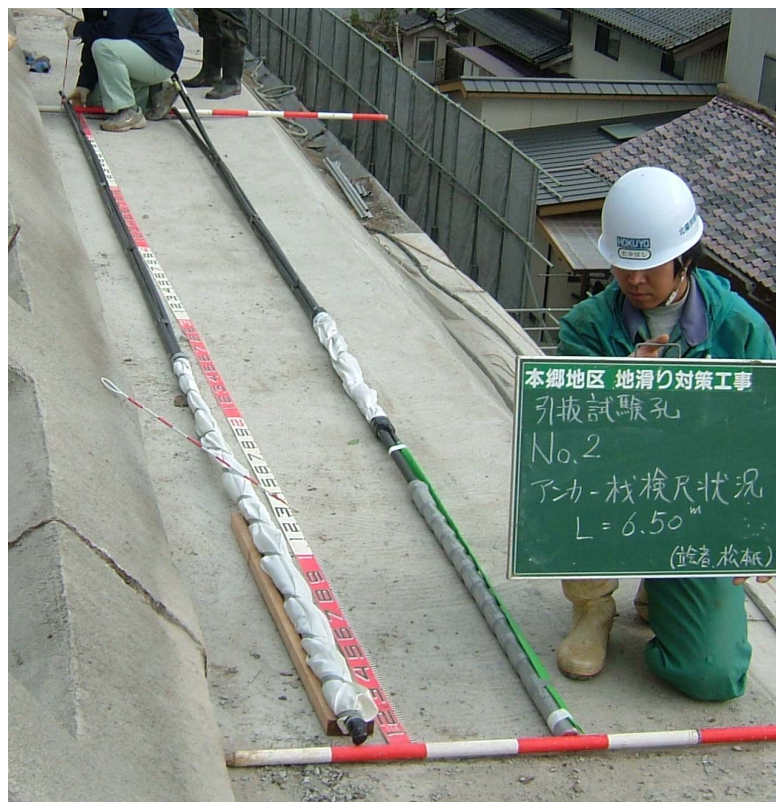
写真 3.2.1 試験用アンカー体組立加工状況（300Ws 型） 右：アンカー体拘束具とパッカー取り付け状況（標準タイプ） 左：グラウト逸出対策として、アンカー体全体を布パッカーで被覆したものの
