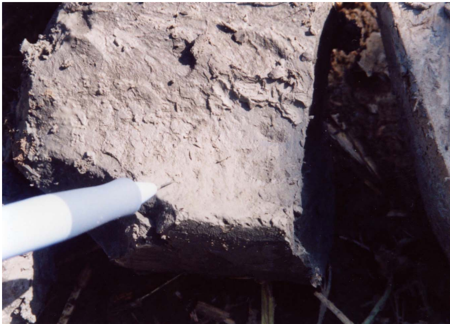
写真 1.6.1 摩擦型アンカーの引抜け要因となりやすいアンカー孔壁の粘土化状況（泥岩： q_u=1.1\text{N/mm}^2 ）
